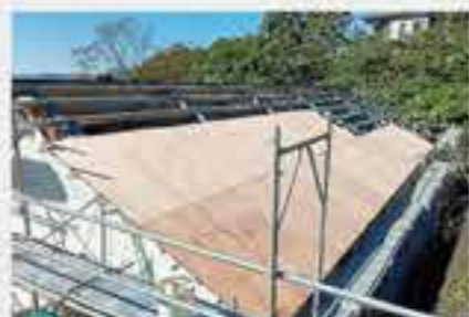
鋪設防水夾板
