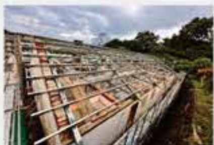
搭建鋼構結構
