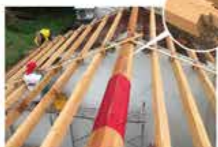
更換主副棟樑
