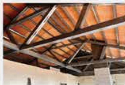
鋪設防水夾板
