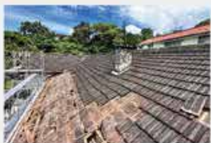
移除舊瓦、舊結構
