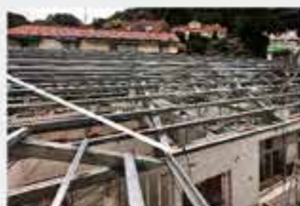
搭建鋼構結構
