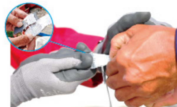
7 TPO焊前測試
