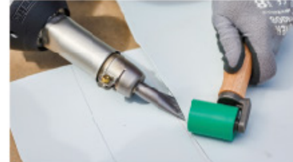
6 開機、TPO焊接
