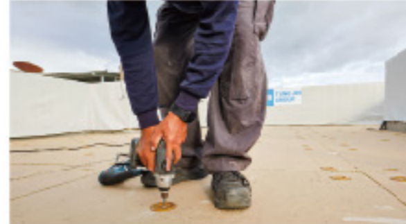
1 安裝隔熱板、固定底部焊片
